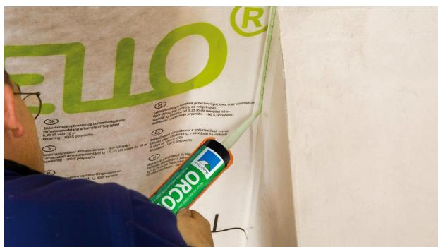
**12a. Соединение с оштукатуренным дымоходом (утепленный или двухстеночный)**
