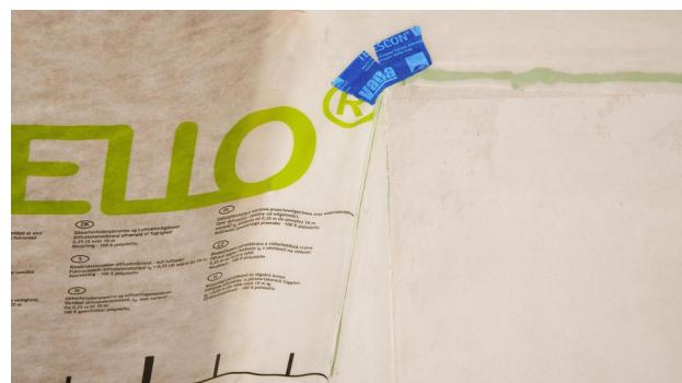
**12b. Соединение с оштукатуренным дымоходом (утепленный или двухстеночный)**
