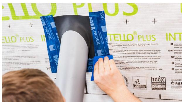
**13. Соединение с трубами и кабелем**
